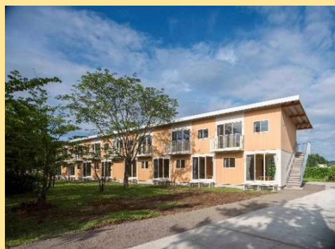
2024年国土交通大臣賞 DLT恒久仮設住宅
